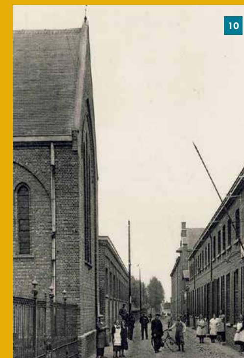
Nieuwstraat. Links de kapel van de Broeders, rechts Rijkswachthuisjes.
